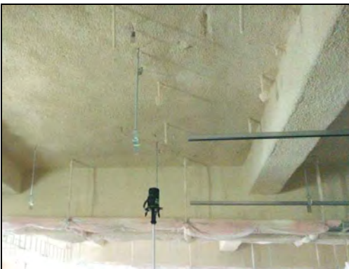
【外部に面する天井への断熱材吹付】
