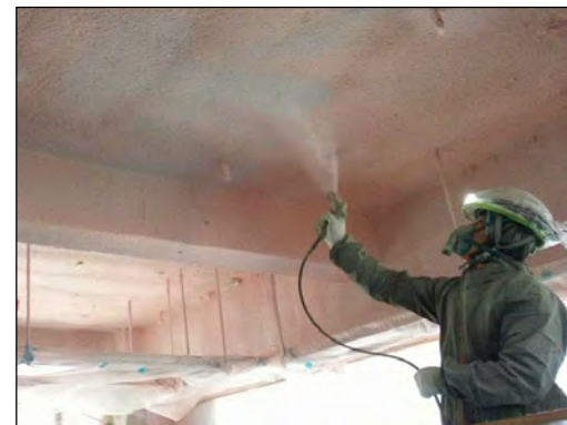
【外部に面する天井への断熱材吹付】
