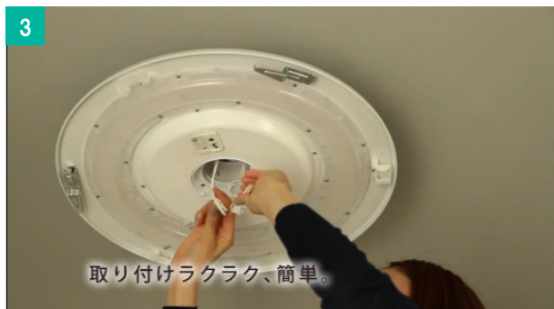
アダプターから出ているコネクタ端子を 本体側の端子口に差し込みます。
