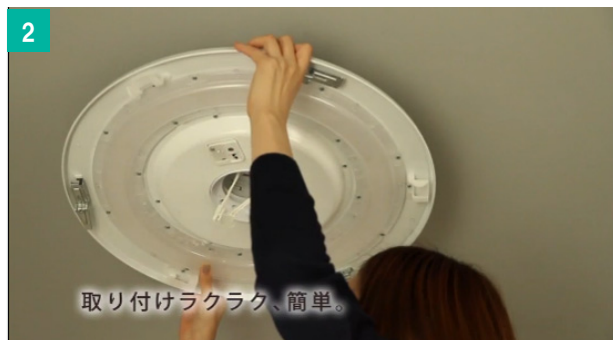
アダプターに本体中央部の丸穴を合わせ、 本体を天井に押し上げます。
